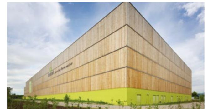
Das Hochregallager von Alnatura bei Lorsch: Natürliche Kühlung über eine massive, tief im Erdreich versenkte Betonbodenplatte.
